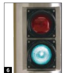
6 Zufahrtsregelung durch einseitige oder zweiseitige Ampelleuchten (rot/grün)
